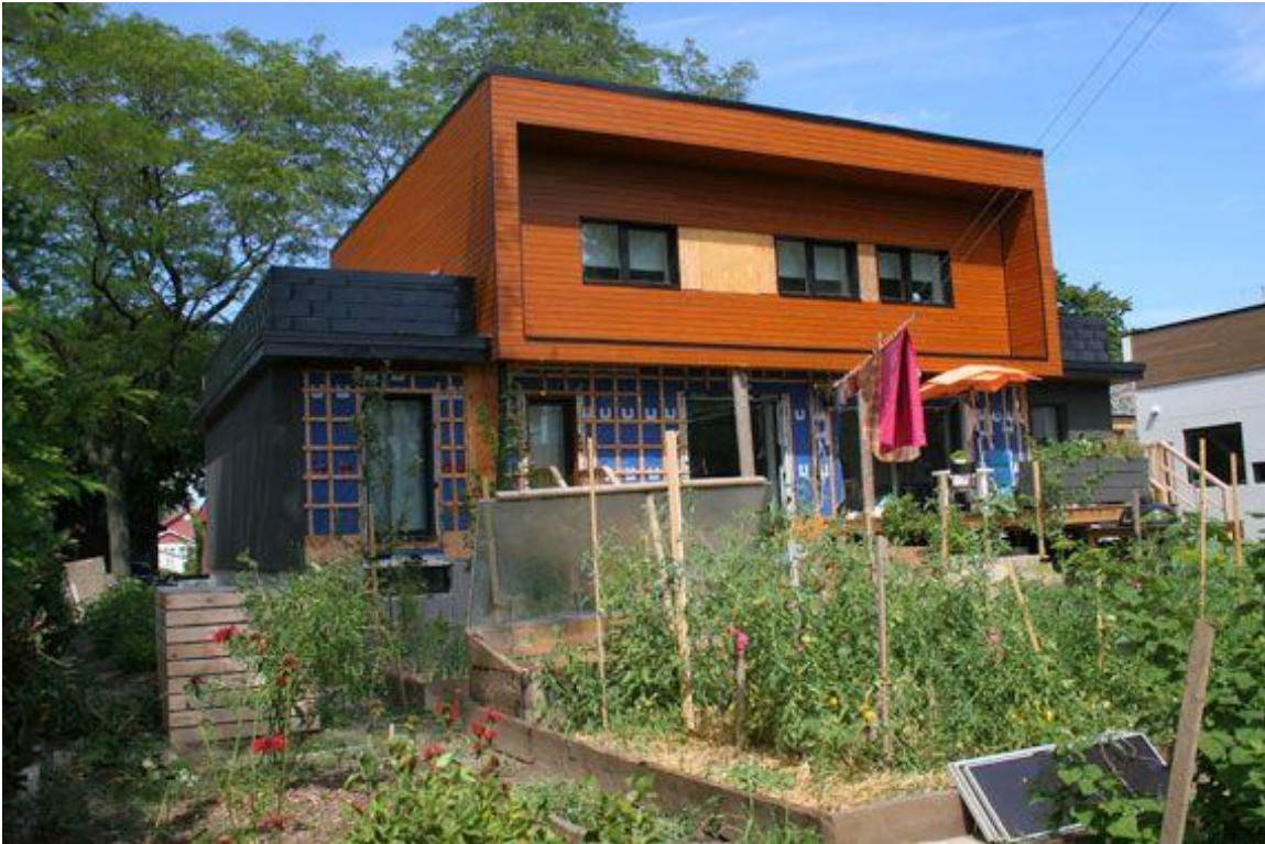
Figure 3 Maison Ozalée dans le quartier Ahuntsic, Montréal Source : ozalee-passive.com
